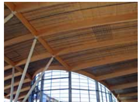
Größte Holzbaustelle Europas.
