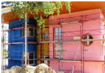
Die Arbeiten gehen zügig voran und der Zeitplan wird eingehalten.
