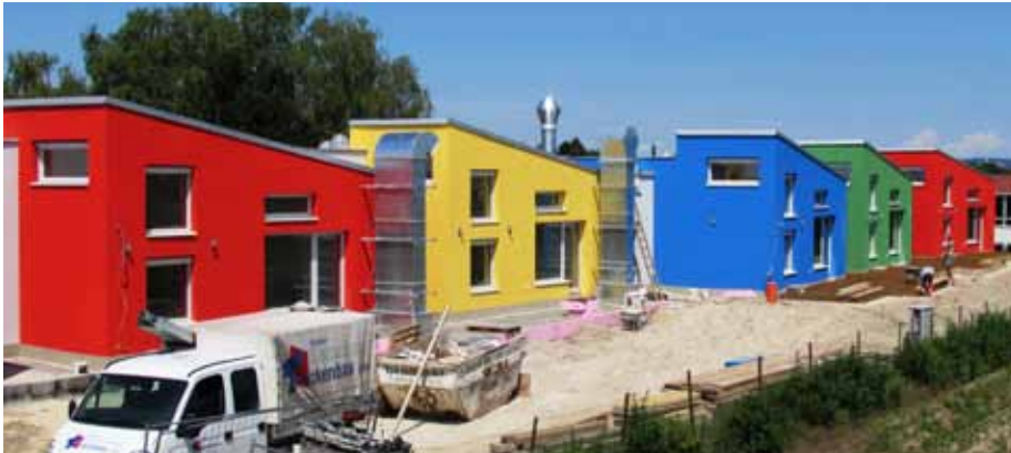
Der Neubau wird im August provisorisch für den Sommerbetrieb bezogen. Kindergartenbeginn ist am 7. September 2015.
