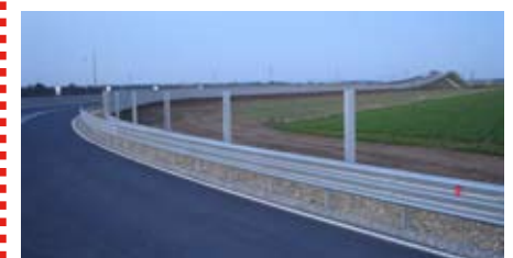
Lärmschutzwände noch nicht fertig
