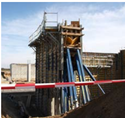
Die Brücke wird illegal gebaut.
