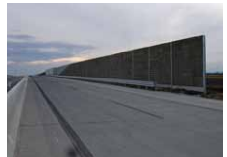
Die Lärmschutzwand neben Kapellerfeld ist mittlerweile auch durchgehend errichtet.
