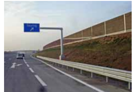
Die tiefgesetzte Autobahn und die fertigen Lärmschutzwände bei Ausfahrt Seyring.
