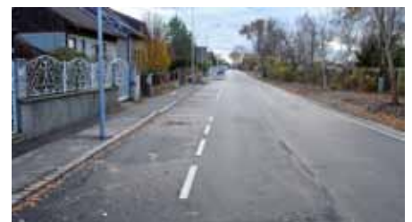
Der sanierte Grenzweg.
