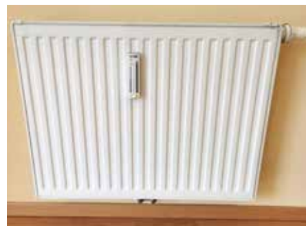
Heizung winterfit machen (Foto: zvg)
