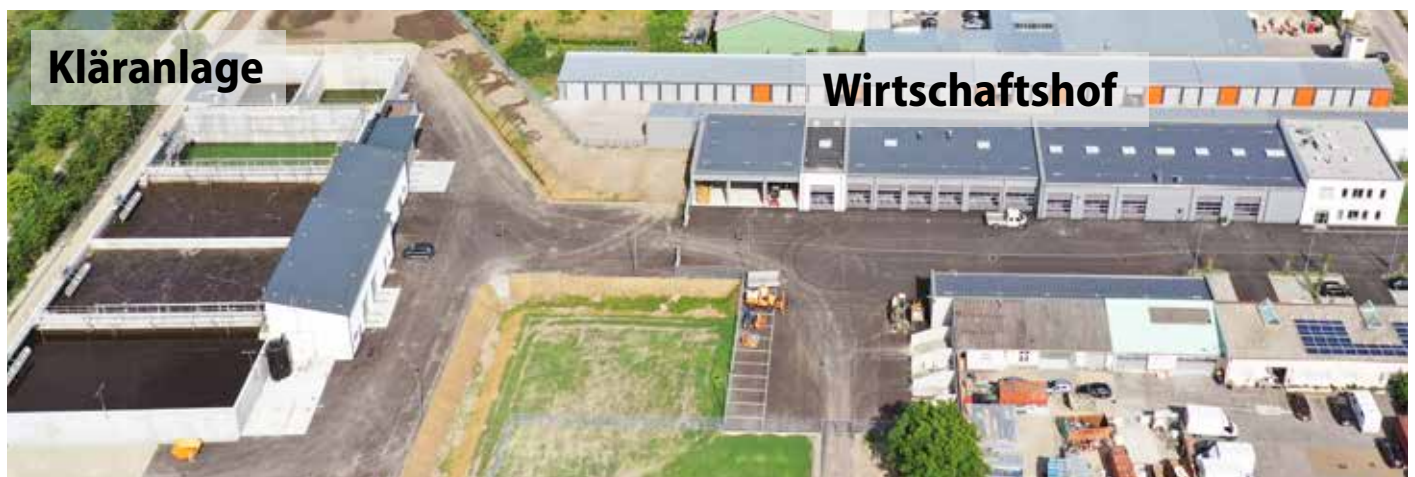
Links sind die 4 Klärbecken, sowie das Becken für den Klärschlamm und für das gereinigte Wasser zu erkennen. Das Wirtschaftshofgebäude umfasst Büroflächen, Lager, Werkstätte und Fahrzeughallen. (Foto: CityCopterCam; Drohnfoto vom Juni 2022)
