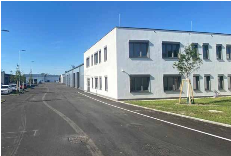
Der neue Wirtschaftshof der Stadtgemeinde im Vordergrund, die Kläranlage im Hintergrund. (Foto: GGK)
